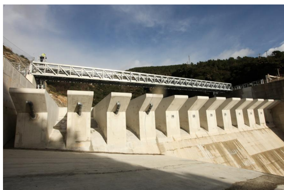
EVACUATEUR DE CRUE MALARCE
