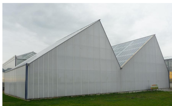
SERRE À HAUTES PERFORMANCES ENERGÉTIQUES
