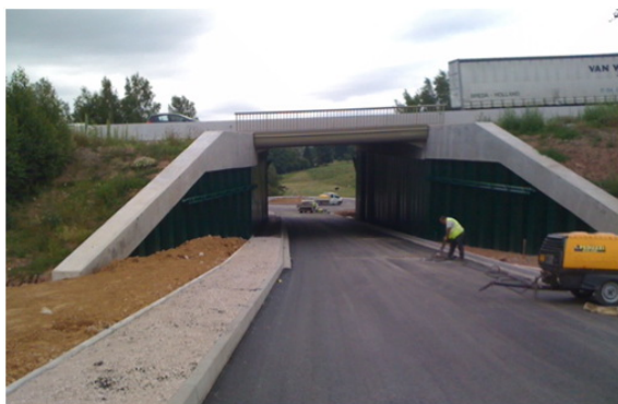
PASSAGE INFÉRIEUR ZAC DES TERRES SAINT JEAN (88)
