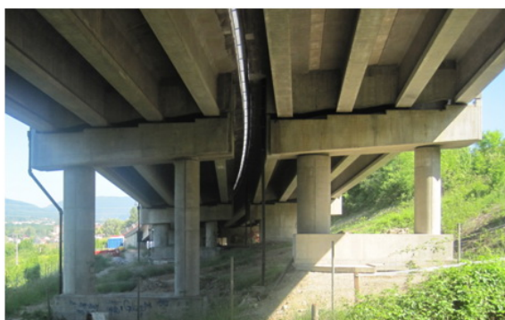
RÉHABILITATION DU VIADUC DU BOIS D'ARLAUD
