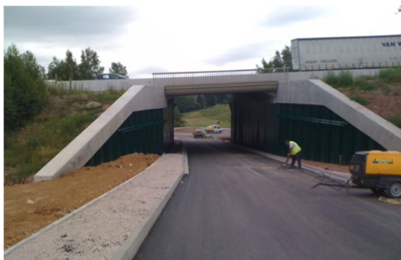
PASSAGE INFÉRIEUR ZAC DES TERRES SAINT JEAN (88)
