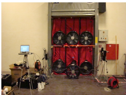
INSTALLATION D'ESSAIS D'UN BÂTIMENT DE GRAND VOLUME
