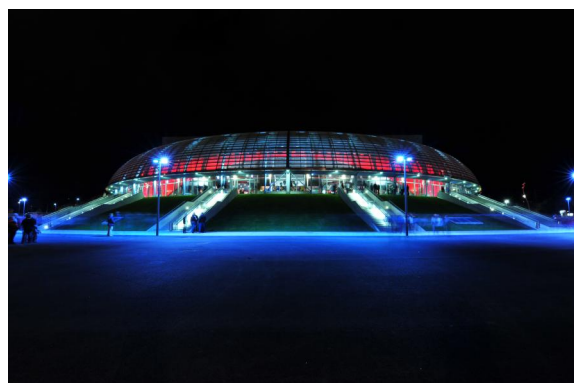
COMPLEXE PLURIFONCTIONNEL LE PHARE - CHAMBÉRY
