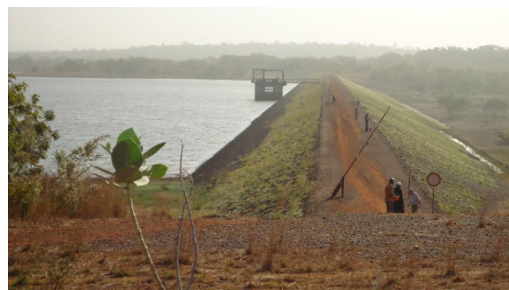
RECHERCHE DE FUITES SUR UN BARRAGE EN AFRIQUE DE L'OUEST
