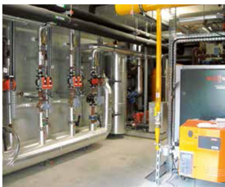
INSTALLATION D'UNE CHAUFFERIE
