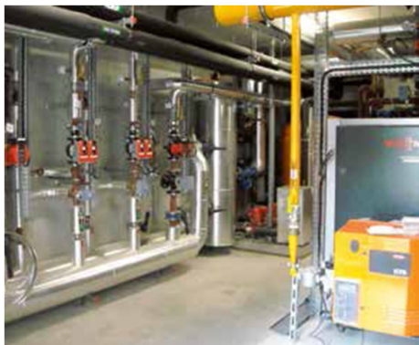
INSTALLATION D'UNE CHAUFFERIE
