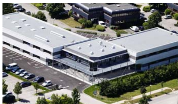
IMPLANTATION DE DFD À SAVOIE TECHNOLAC
