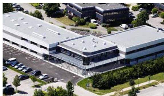
IMPLANTATION DE DFD À SAVOIE TECHNOLAC
