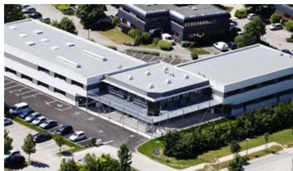
IMPLANTATION DE DFD À SAVOIE TECHNOLAC
